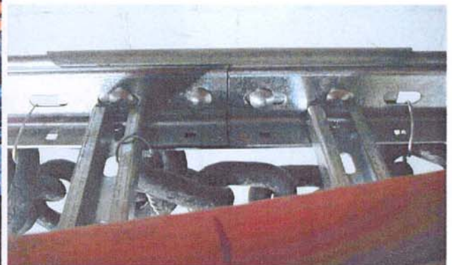
Bild A7.18: Stoßstelle Leiter von innen
