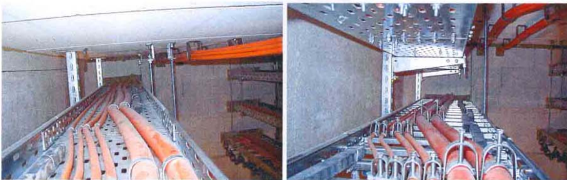
Bild A8.6 und A8.7: Versatz der Kabel auf der oberen Rinne und der mittleren Leiter
