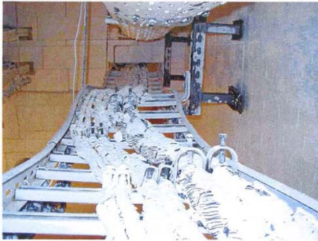
Bild A7.13 und A7.14: Blick auf die Kabeleiter (400 mm) nach links und rechts
