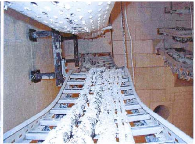
Bild A7.13 und A7.14: Blick auf die Kabeleiter (400 mm) nach links und rechts
