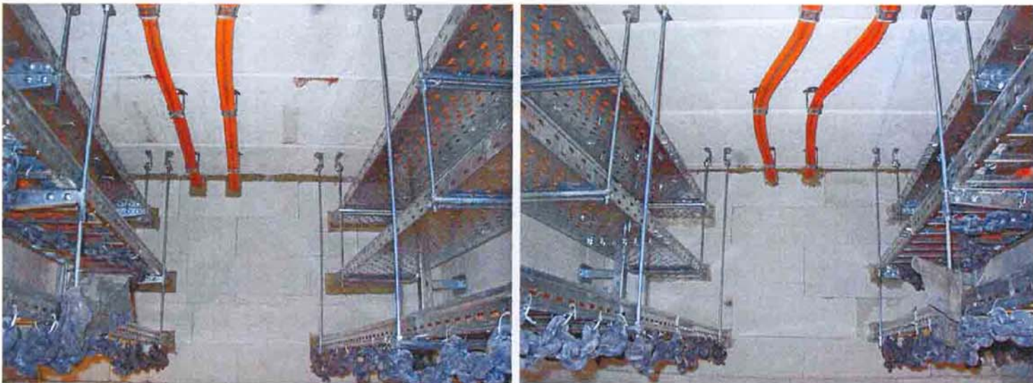
Bild A9.1 und A9.2: Deckenverlegung mit Sammelhaltern, linke und rechte Ofenwand
