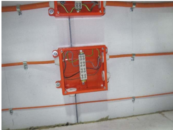
Bild A7.19 und Bild A7.20 System 15.1 Einzelverlegung und Verbindungsmittel PMO3
