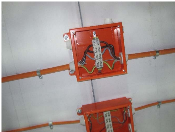
Bild A7.21 und Bild A7.22 System 15.2 Einzelverlegung und Verbindungsmittel PMO3
