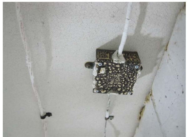
Bild A7.23 und Bild A7.24 System 16.1 Einzelverlegung und Verbindungsmittel PMO1
