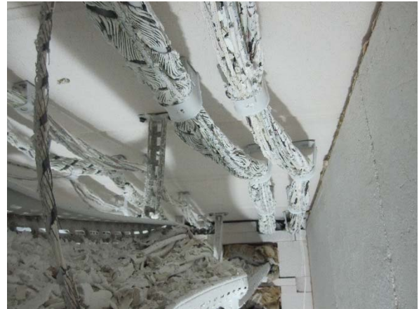
Bild A7.13 und A7.14 System 7 und 8, Kabelschelle OZO
