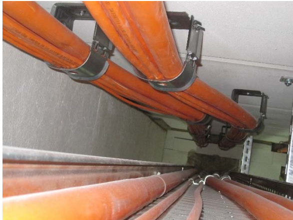
Bild A7.13 und A7.14 System 7 und 8, Kabelschelle OZO
