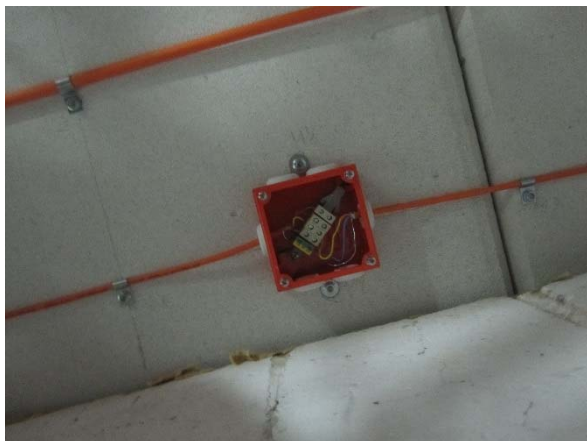
Bild A7.23 und Bild A7.24 System 16.1 Einzelverlegung und Verbindungsmittel PMO1
