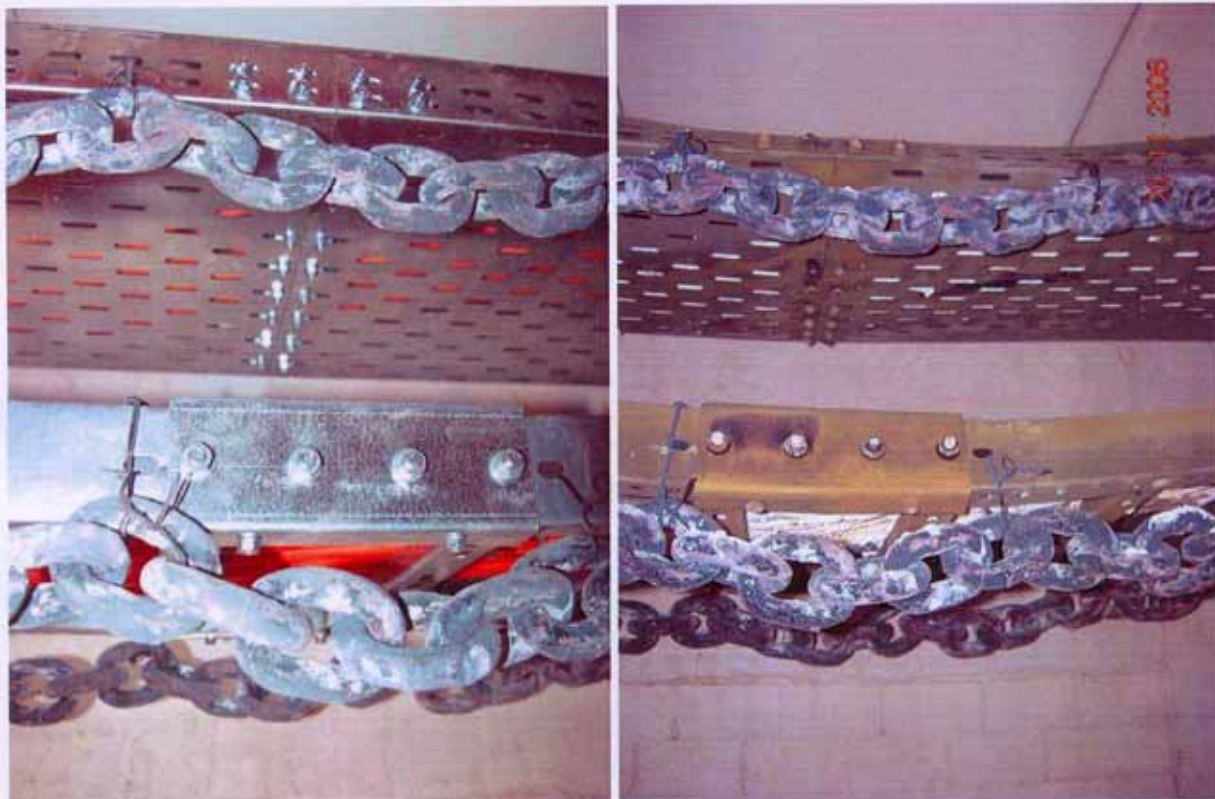
Bild A7.5 und A7.6: Stoßstelle Leiter und Rinne 400 mm vor und nach dem Versuch
