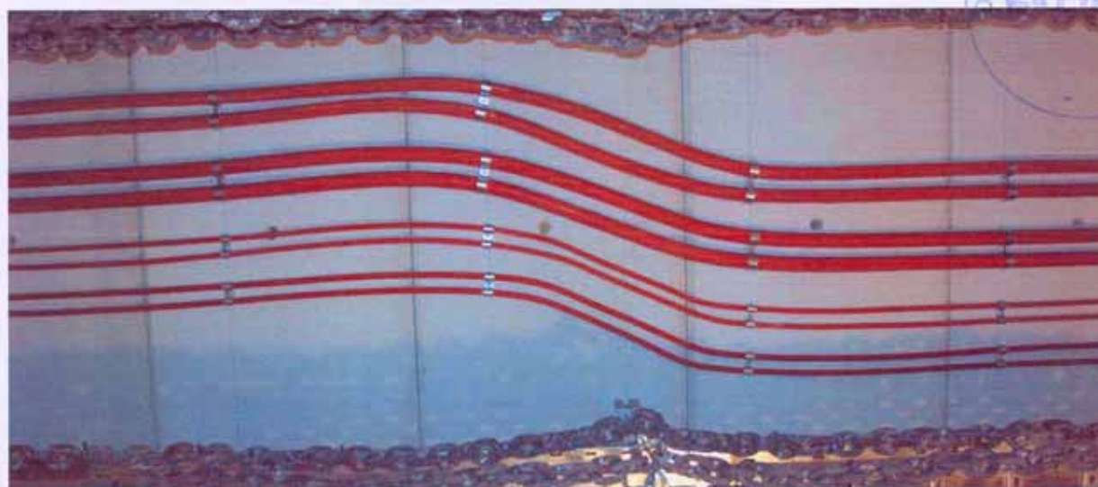
Bild A9.3: Versatz in der Deckenverlegung mit Doppelschellen UEF
