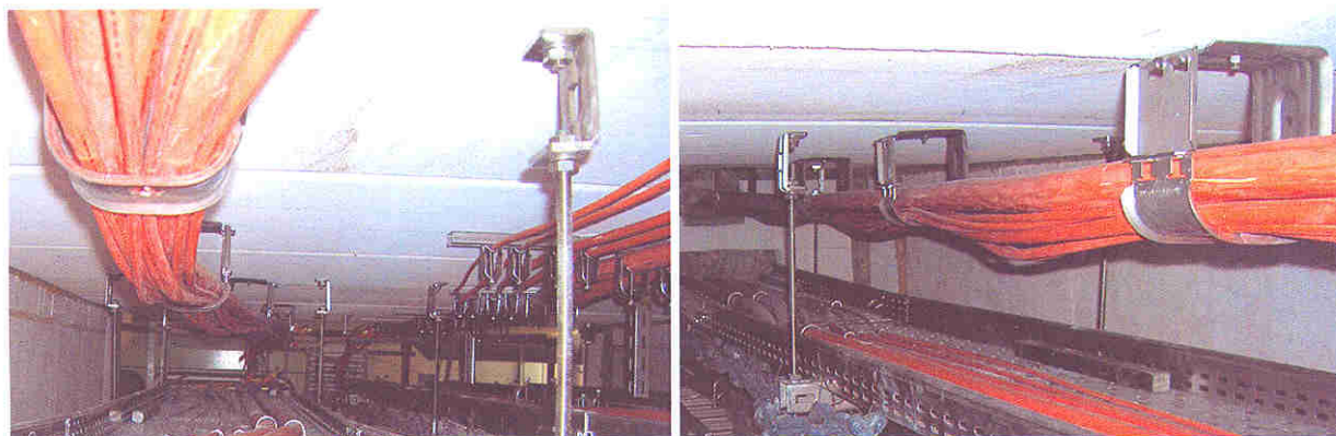
Bild A9.1 und A9.2: Deckenverlegung mit Sammelhalterungen vor dem Versuch
