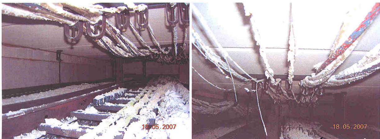
Bild A10.3 und A10.4: Deckenverlegung mit Bügelschellen nach dem Versuch
