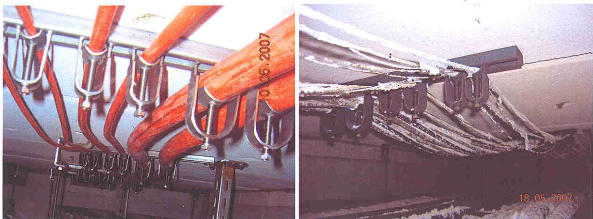
Bild A10.5 und A10.6: Deckenverlegung mit Bügelschellen, Detail Bügelschellen
