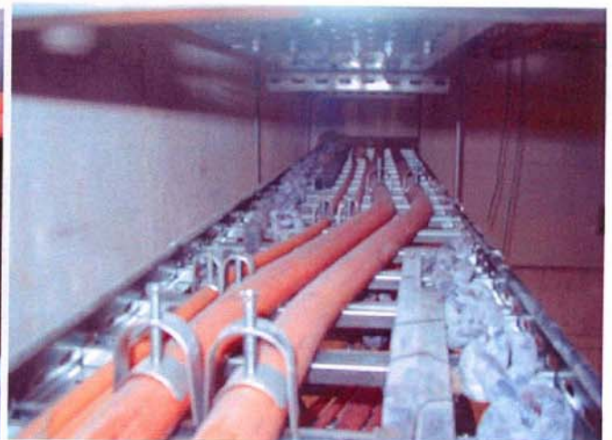
Bild A8.5 und A8.6: Versatz der Kabel auf der oberen Rinne und der mittleren Leiter
