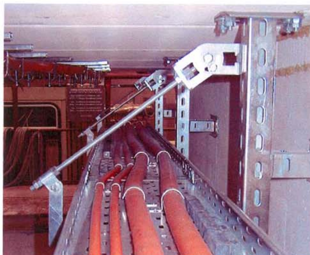
Bild A7.5 und 7.6: Versatz der Kabel, Rinne (links) und Leiter (rechts)
