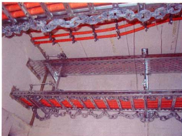
Bild A7.1 und A7.2: Wandauslegerverlegung vor dem Versuch, Blick nach links und rechts
