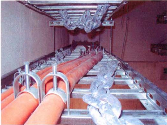
Bild A8.7: Versatz der Kabel auf der unteren Leiter
