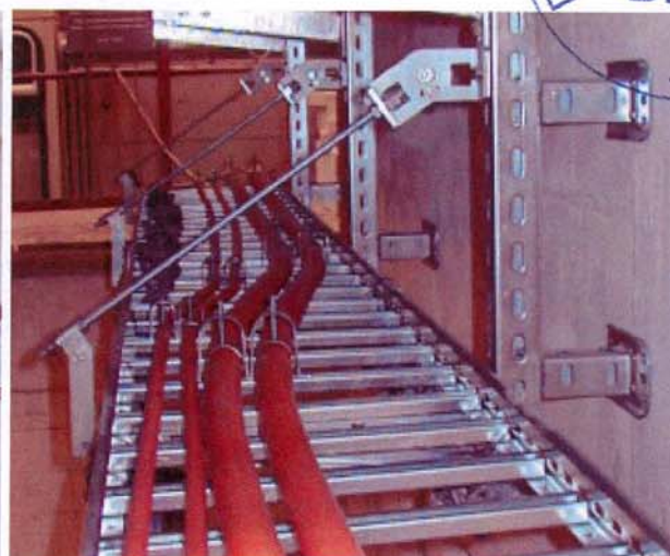
Bild A7.5 und 7.6: Versatz der Kabel, Rinne (links) und Leiter (rechts)
