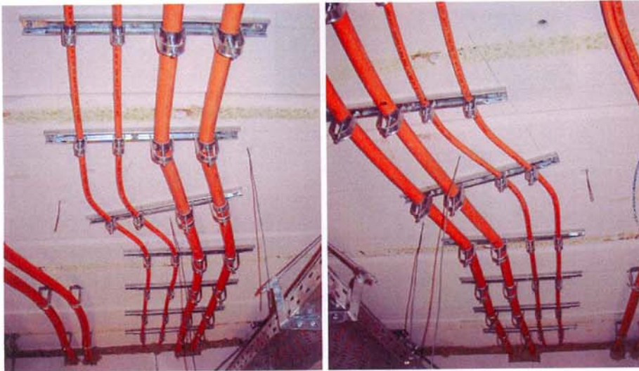
Bild A9.1 und A9.2: Deckenverlegung mit Bügelschellen, linke und rechte Ofenwand
