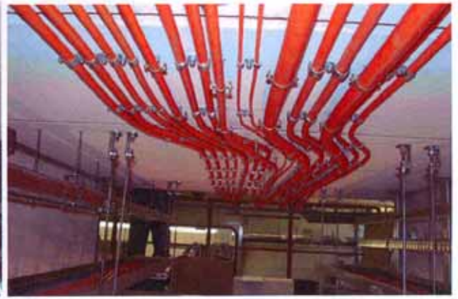
Bild A9.1 und A9.2: Deckenverlegung mit Kabelschellen, von rechter Ofenwand aus gesehen
