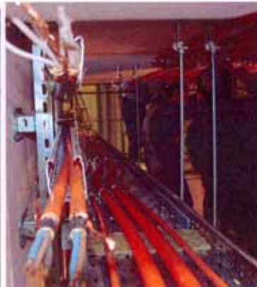
Bild A7.6: Versatz der Kabel (Rinne) und Ausführung Rinnenschelle mit Rinne
