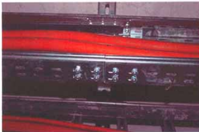
Bild A7.9: Stoßstelle Rinne 300 mm außen
