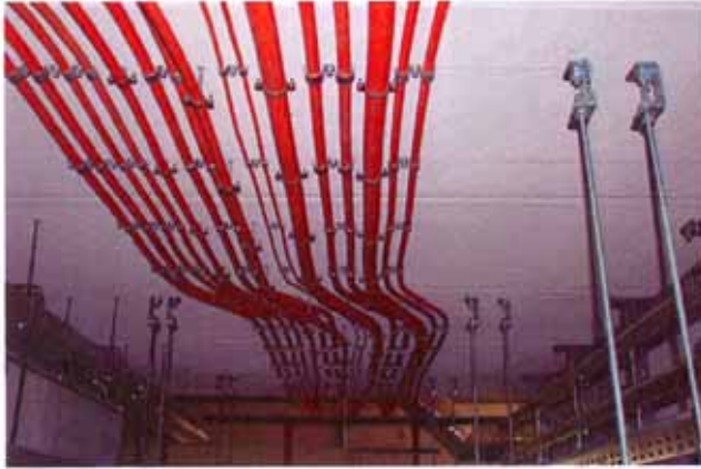
Bild A9.1 und A9.2: Deckenverlegung mit Kabelschellen, von rechter Ofenwand aus gesehen
