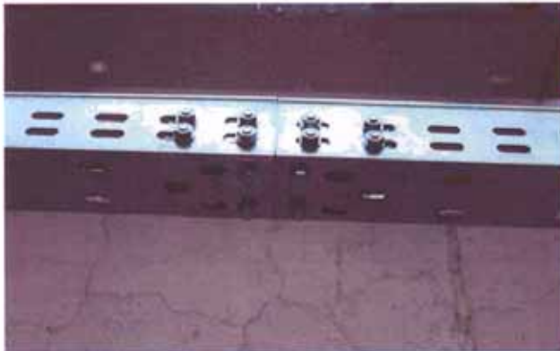
Bild A7.7: Stoßstelle Rinne 50 mm außen
