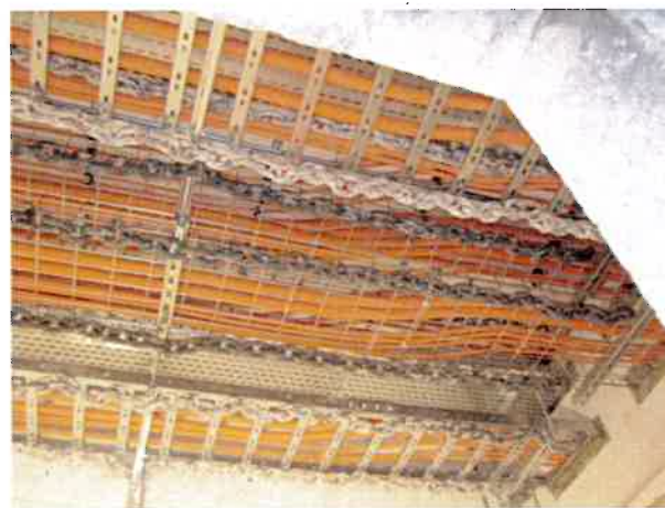
Bild A6.4 Blick in Ofen, Stirnwand rechts
