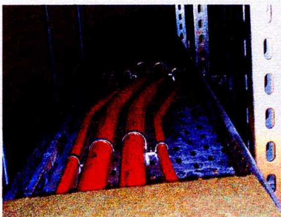
Bild A7.5 Versatz der Kabel auf der Rinne
