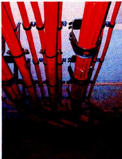
Bild A9.1: Deckenverlegung von rechter Ofenwand aus gesehen
