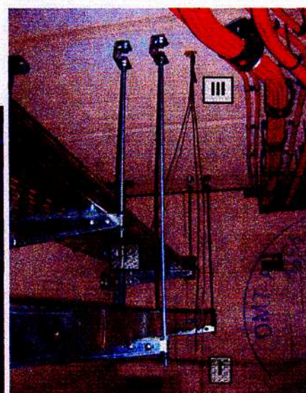
Bild A7.12: Positionen der Thermo- elemente I bis III
