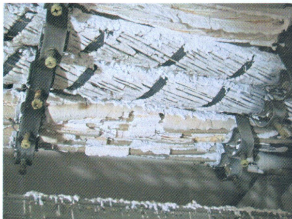
Bild A7. 18 Einzelverlegung UKO1 + SDPO 700, nachher
