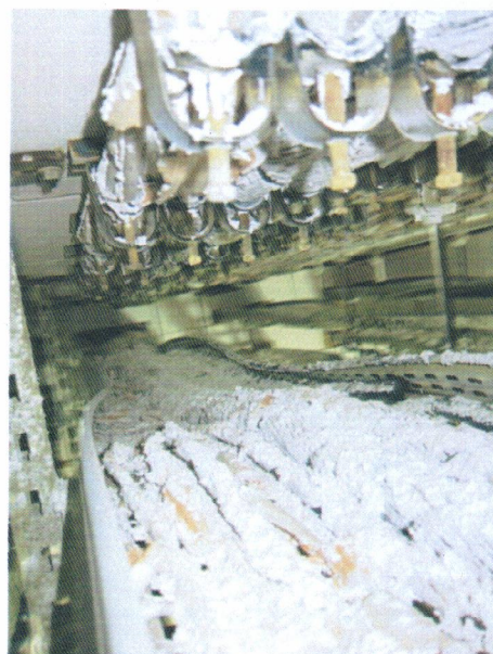
Bild A7.4 Kabelrinne 400, rechts nachher
