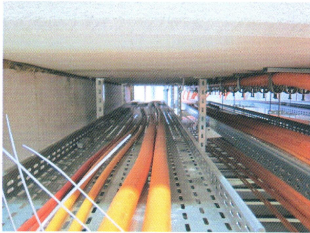
Bild A7.1 Kabelrinne 400, links vorher
