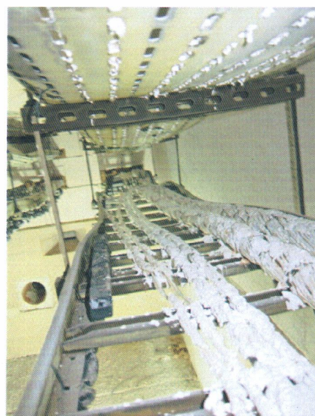
Bild A7. 16 Kabelleiter 400, rechts nachher
