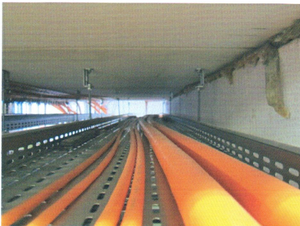
Bild A7. 11 Kabelrinne 400, rechts vorher
