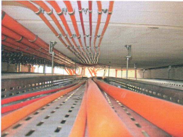
Bild A7. 9 Kabelrinne 400, links vorher
