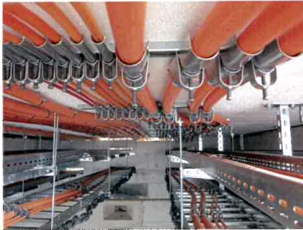
Bild A7. 17 Einzelverlegung UKO1 + SDPO 700 +RO2, vorher
