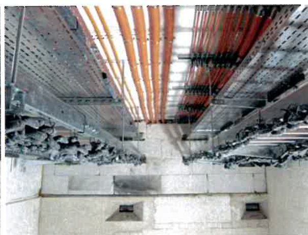
Bild A6.4 Blick in Ofen, Stirnwand rechts
