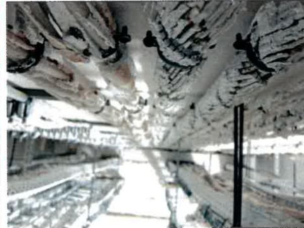
Bild A7. 20 Deckenverlegung KSA, nachher
