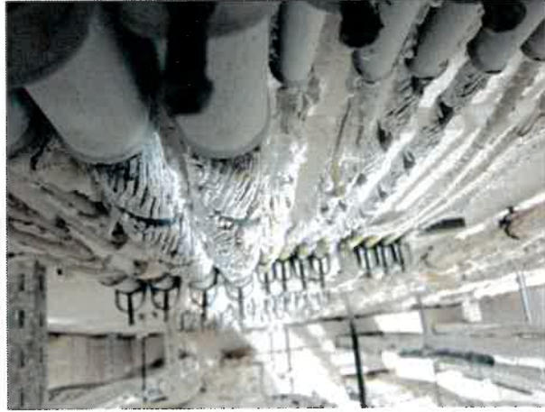
Bild A7. 18 Einzelverlegung UKO1 + SDPO 700 +RO2, nachher
