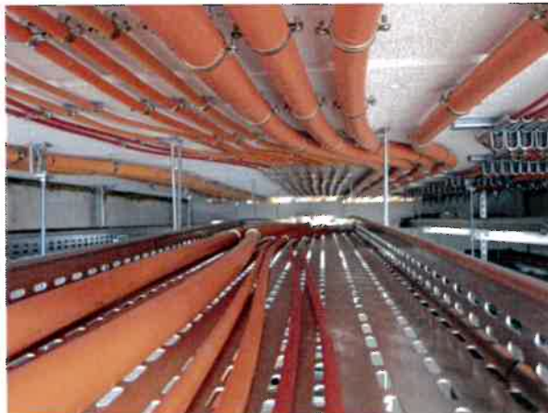
Bild A7. 19 Deckenverlegung KSA, vorher
