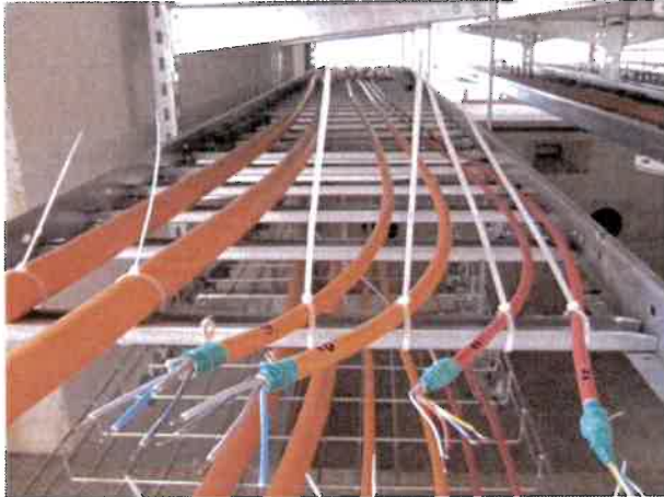
Bild A7.5 Kabelleiter 600, links vorher
