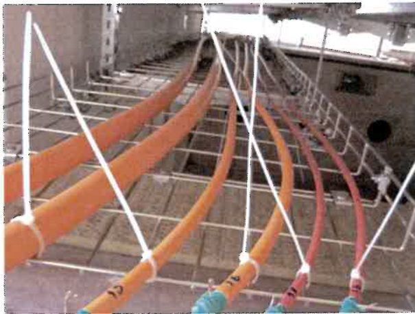
Bild A7.9 Kabelgitter 600, links vorher
