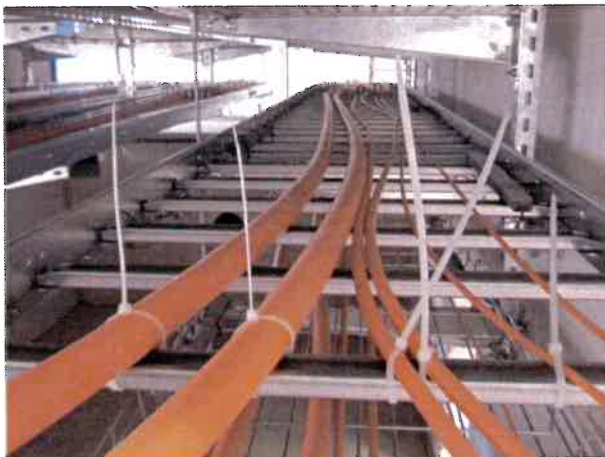
Bild A7.5 Kabelleiter 600, links vorher
