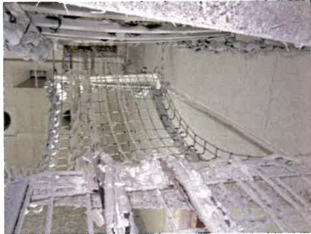
Bild A7.12 Kabelgitter 600, rechts nachher
