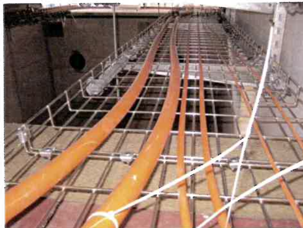
Bild A7.9 Kabelgitter 600, links vorher
