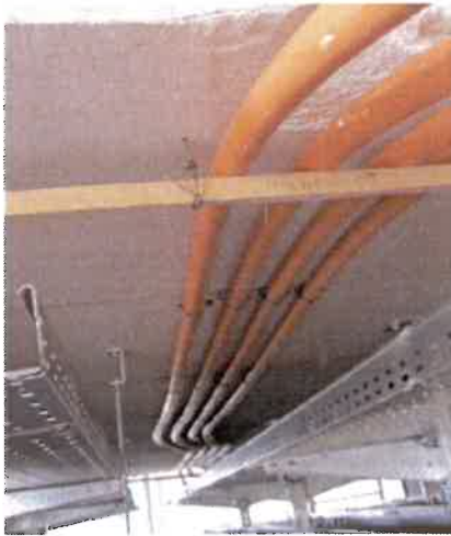
Bild A7.21 Deckenverlegung, links vorher
