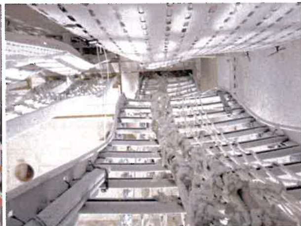
Bild A7.6 Kabelleiter 600, links nachher
