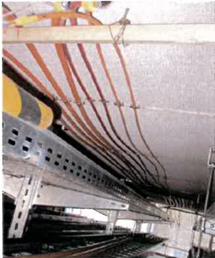
Bild A7.23 Deckenverlegung, rechts vorher
