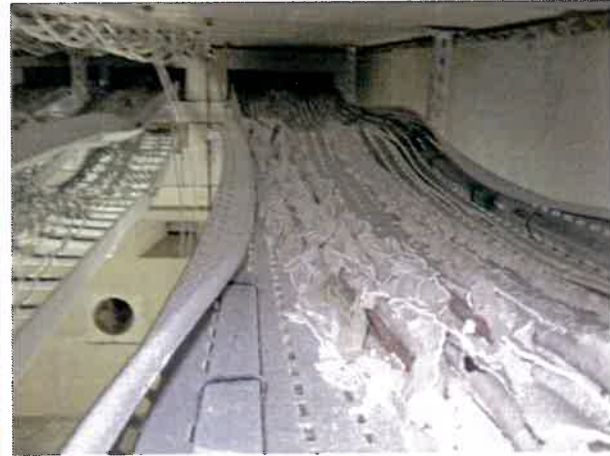
Bild A7.2 Kabelrinne 600, links nachher
