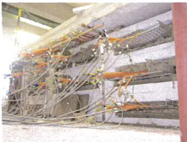
Bild A6.1 Blick auf Ofenwand links
