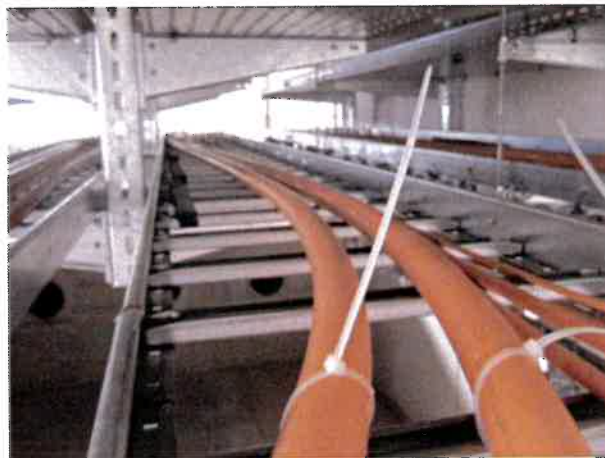
Bild A7.17 Kabelleiter 400, links vorher
