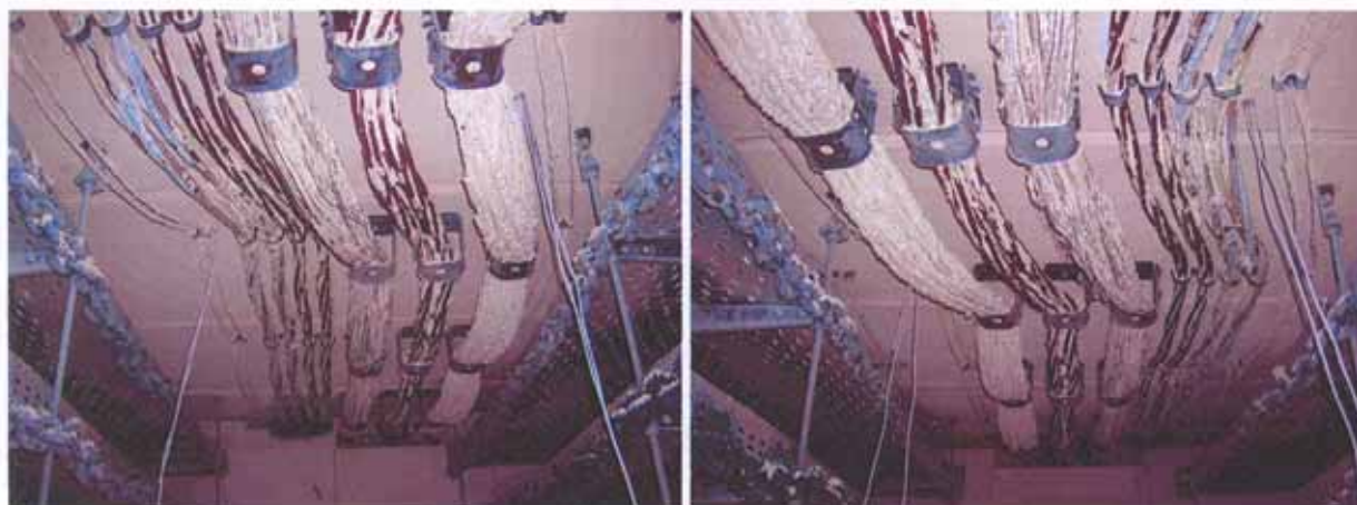
Bild A9.3 und A9.4: Deckenverlegung mit Kabelschellen und Sammelhalterungen, von linker und rechter Ofenwand aus gesehen nach dem Versuch
