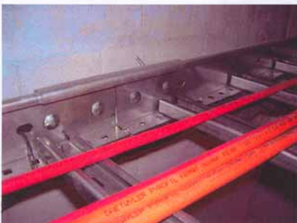
Bild A7.5: Stoßstelle Leiter 400 mm, innen
