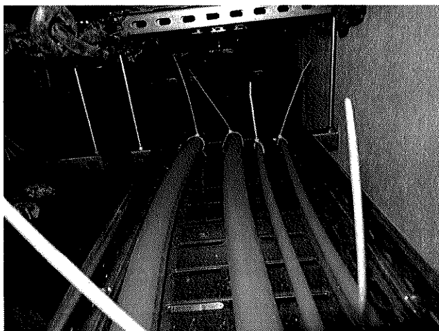
Bild A7. 15 Kabelrinne 300, rechts vorher
