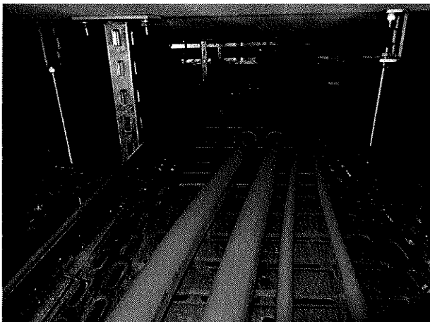
Bild A7. 3 Kabelrinne 400, rechts vorher
