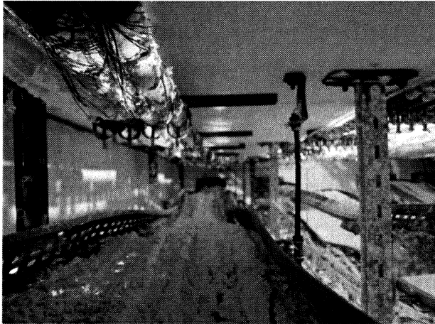
Bild A7. 14 Einzelverlegung UKO1 mit RO2, 50mm 2
