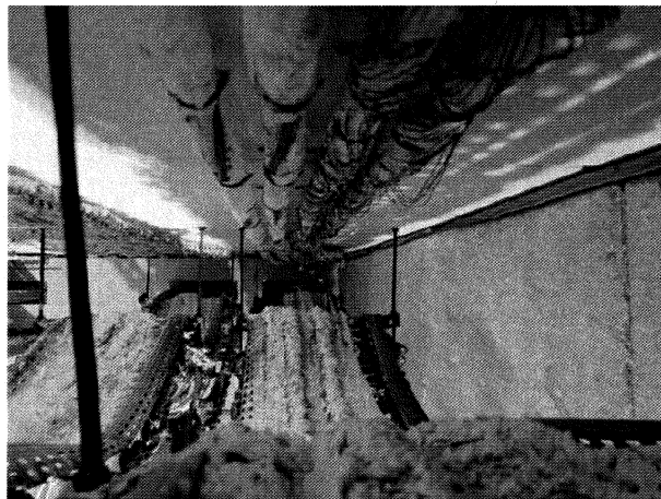
Bild A7. 21 Einzelverlegung UDF 50mm 2
