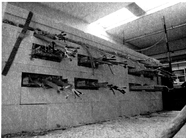
Bild A6. 1 Blick auf die Ofenwand links
