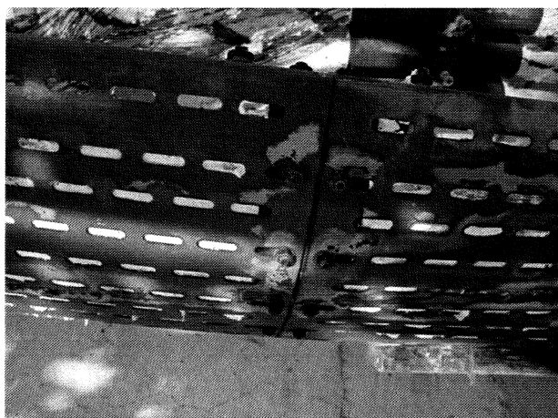
Bild A7. 3 Kabelrinne 300, Stoß nachher (System 1)
