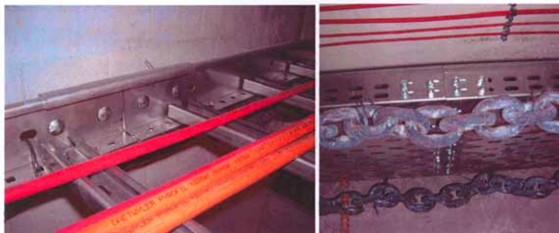
Bild A7.5: Stoßstelle Leiter 400 mm, innen
