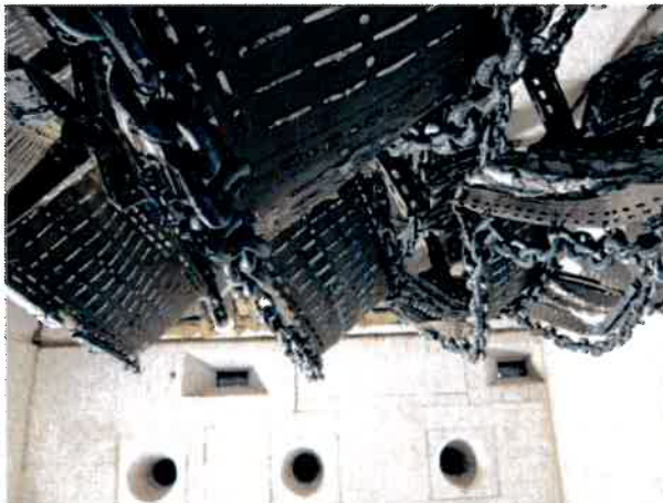
Bild A7. 31 Brandraum, linke Wand nachher
