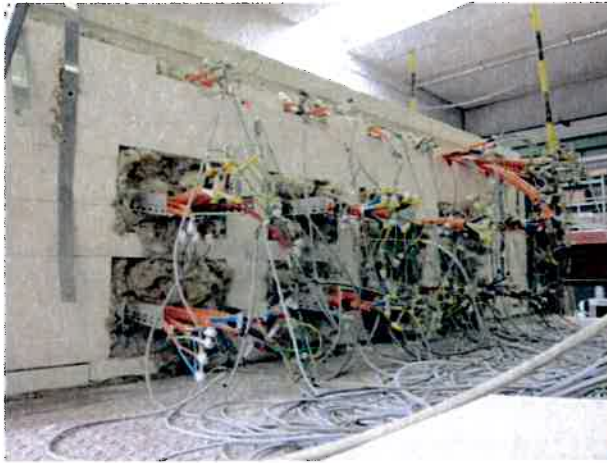
Bild A6. 1 Blick auf die Ofenwand links
