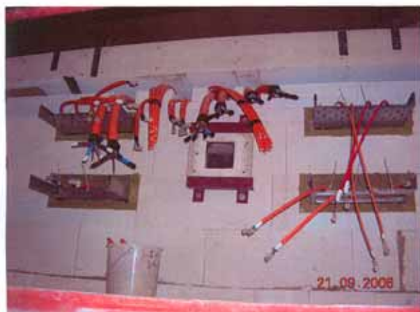
Bild A6.1: rechte Ofenwand zugemauert
